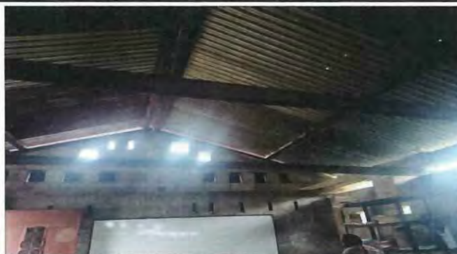
Foto 2: Cambio de costaneras de maderas deteriorada, apolilladas, a costaneras de metal reforzadas.
